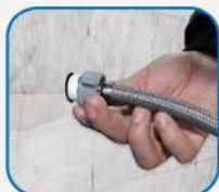
4. Ubicar el terminal macho en el punto de agua y con la ayuda del adaptador de ajuste manual realizar el ajuste.
